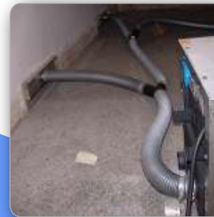
Trocknung mit Randschichtdüsen
