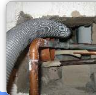
Hohlwandtrocknung
